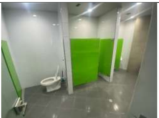
Desprendimiento de puertas de los baños que no han sido reinstaladas y generan inutilización de sanitarios
