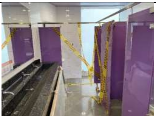
Desprendimiento de puertas de los baños que no han sido reinstaladas y generan inutilización de sanitarios
