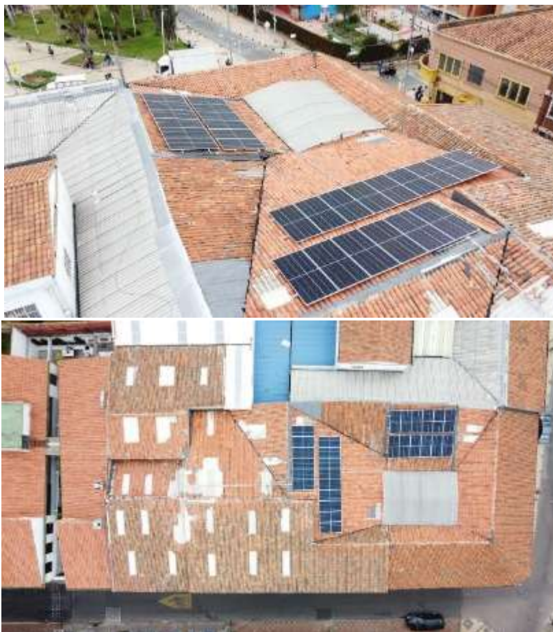
Instalación de sistema fotovoltaico – Sede casa de la Participación ALS 2026.
