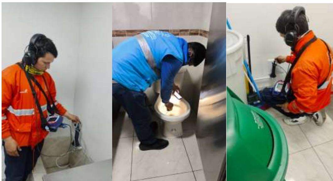
Inspecciones unidades hidrosanitarias ALS 2026.
