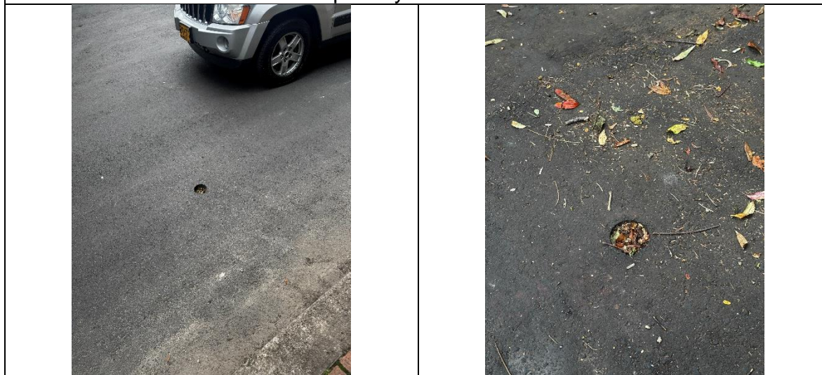
Extracción de núcleos sin que hayan sido sellados en el CIV 13002083
