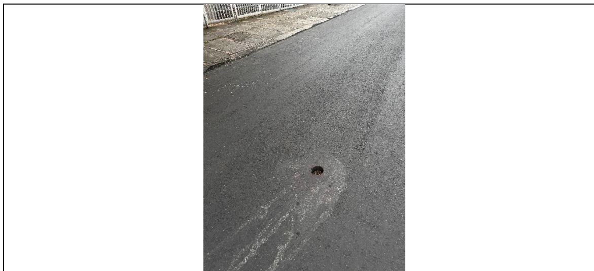
Extracción de núcleos sin que hayan sido sellados en el CIV 13002122
