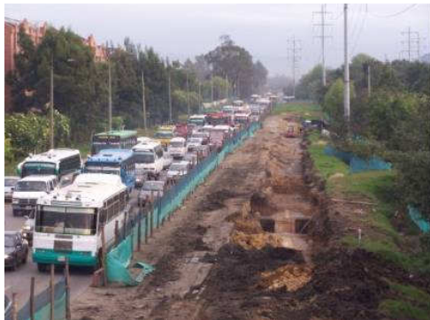
Durante las obras – 2009
