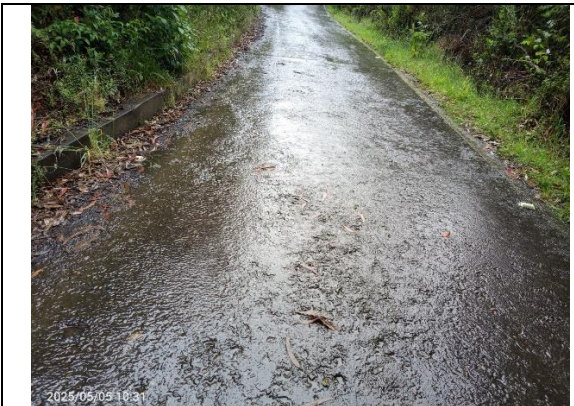
Observación No 1, CIV 2001917, Desprendimientos de material y desgaste prematuro de la calzada, en la esquina de la Calle 46 con Cra 7.
