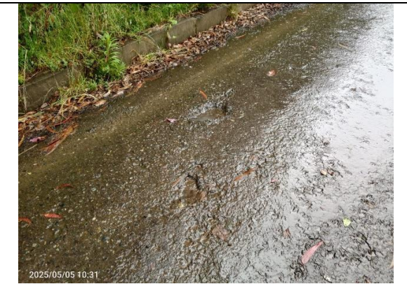
Observación No 1, CIV 2001917, Desprendimientos de material y desgaste prematuro de la calzada, en la esquina de la Calle 46 con Cra 7.
