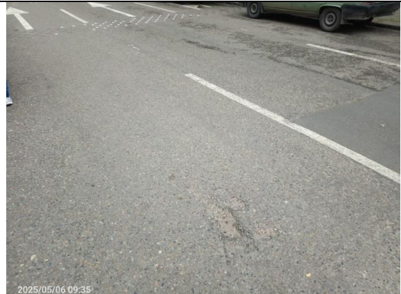
Observación No 1, CIV 2001917, Desprendimientos de material y desgaste prematuro de la calzada, en la esquina de la Calle 46 con Cra 7.
