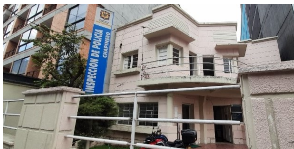
Fotografía 3 Fachada del edificio.
