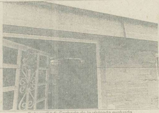
Fotografía 5. Fachada de la vivienda evaluada
